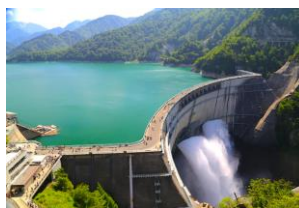
ダム・河川の 管理や制御を行なう 管理団体
